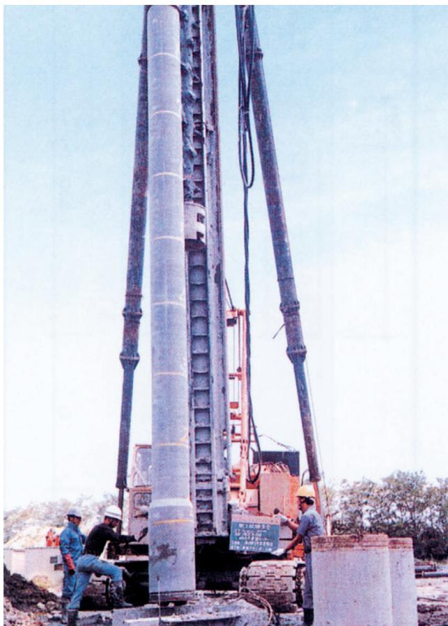
杭の先端部を拡径したTAFCO-STパイルを用いて、大きな鉛直支持力をとれるようにした工法です。
