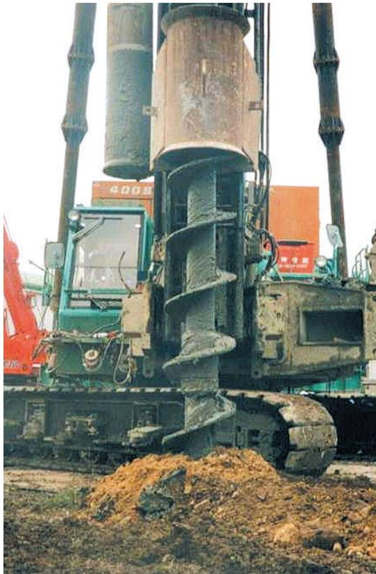
既製杭の施工は打撃によって支持力を確認する方法が最も信頼性が高く、経済的でもあります。しかし低公害型工法の開発は社会的要請であり、昭和40年前後から埋込み杭工法の開発がすすめられました。
