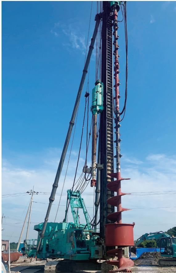
Hyper-ストレートNT工法は、溝付きの専用下杭を根固め部に挿入することにより、セメントミルクとの付着力を向上させ、より強固に杭体と根固め部を一体化させた工法です。オーガにより地盤を先行掘削した後根固め液および杭周固定液を注入し、くいを自沈または回転によって所定の支持層に1Dt(杭先端部径)以上挿入します。上部にはPHC杭、PRC杭、SC杭、ST杭(頭部側を拡頭とする)などの既製コンクリート杭および鋼管杭(上杭)の使用ができます。
