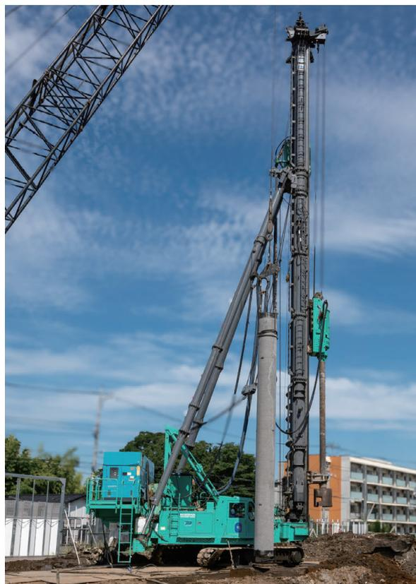
COPITA型プレボーリング工法はコンクリートパイル・ポール協会が施工方法・管理手法を統一し規定した工法です。道路橋示方書に掲載されている土木用のプレボーリング工法に適合した工法として記載されています。
