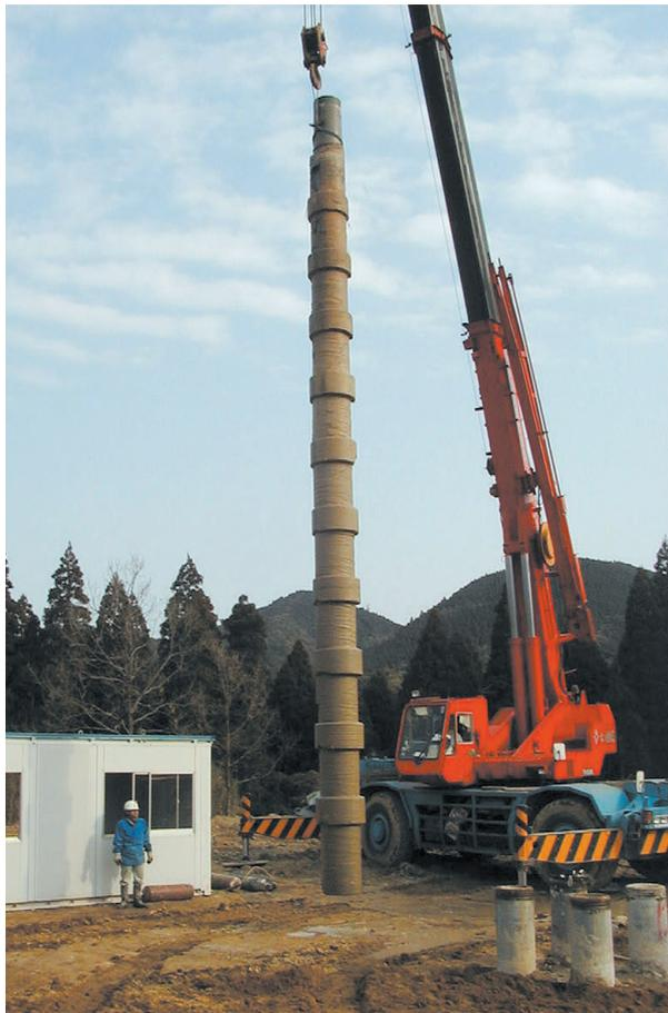
MRX (Milk Revolution X files) 工法は、杭径+100mmの掘削ビットと拡大翼を備える攪拌拡大ロッド(改良拡大部径は改良軸部径+150mm以上)及び拡大翼の開閉が確認できる確認装置等を用いて、地盤に応じた所定速度で、杭周改良液を所定量注入しながら掘削攪拌してソイルセメントと改良柱体を築造します。所定改良深度に達したら、先端固定液に切り替え、攪拌拡大ロッドの拡大翼を開かせ、上下反復することで改良拡大部を築造する。節形状築造が完了したら、拡大翼を閉じ、攪拌拡大ロッドを引き上げます。そして、先端開放型の既製コンクリート杭を自沈または回転によって所定位置に設定する工法です。
