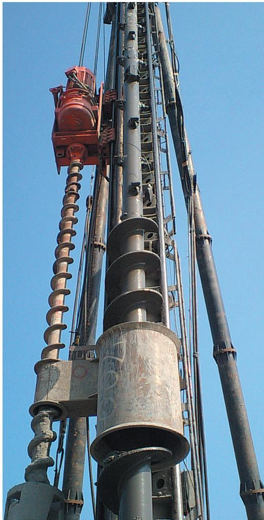
ケムン (Kaiten Milk Negatame) 工法は、掘削ビットの先端から水、又は杭周固定液を注入しながら掘削攪拌し、所定深度に達したら所定量の根固め液を注入して根固め球根部を築造します。
