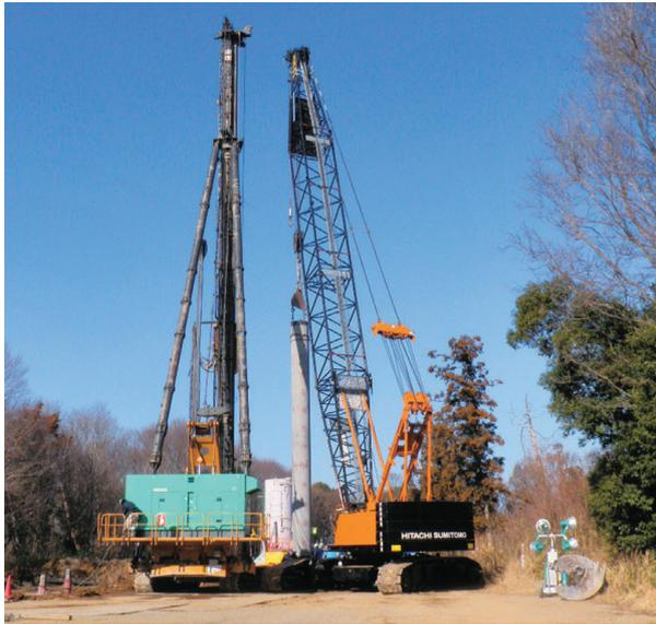
Hyper-ストレート工法は、オーガにより地盤を先行掘削した後根固め液および杭周固定液を注入し、くいを自沈又は回転によって所定の支持層に1D以上挿入する工法です。オーガヘッド、スクリュウ、攪拌ロッド及び連結ロッドなどで構成される掘削攪拌装置を使用し、下図の施工手順の要領で施工します。
