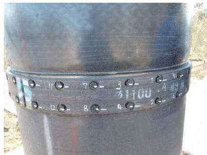
T・P JOINTは下杭と上杭により形成されたテーパー状の突起に、接続プレートのテーパー状の溝を接続ボルトで取り付けることにより嵌合し、杭を接続する形状になっています。
