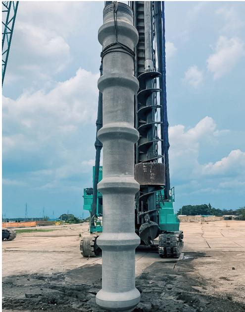
NEWスーパーFK (NEW Super Functional Knotty) 工法は、攪拌翼を有するロッドあるいはスパイラルオーガ及びオーガビットで構成された掘削装置の先端から、掘削液を注入しながら所定径の孔を掘削攪拌し築造します。設計所定深度まで到達したら、オーガ駆動装置を正回転（右回り）の状態掘削装置の上下反復作業を行います。その後、掘削液を根固め液に切り替え所定量を注入し反復後、杭周固定液を注入しながら掘削装置を引き上げます。このようにして、築造した所定量の充填液を注入した孔に杭を自重埋設または回転埋設し、所定深度に設置する工法です。セメントミルク（根固め液、杭周固定液）の材料に高炉セメント（B種）とSF混和材を使用することにより、セメントミルクに膨張効果を与え、杭と地盤との間に膨張圧が働き、大きな摩擦力を発揮できます。
