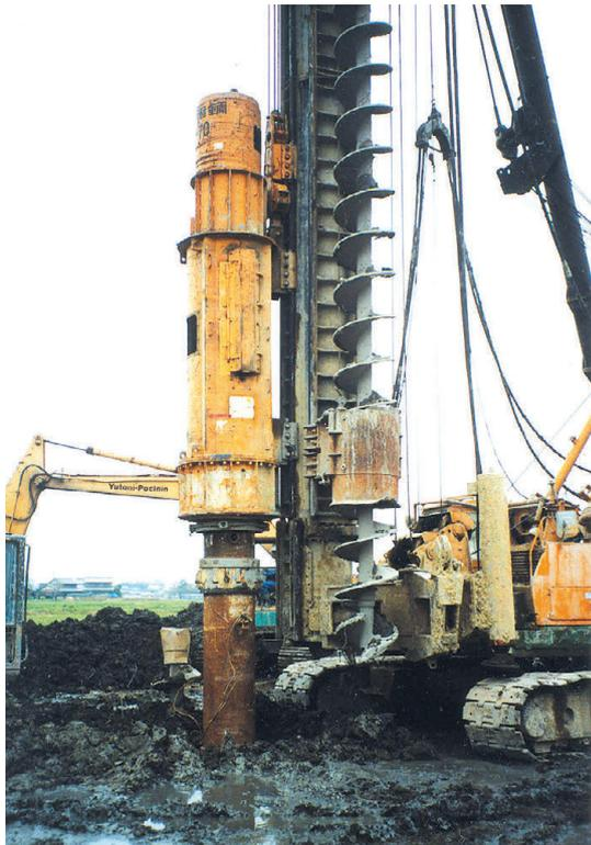
油圧ハンマ工法は打撃工法の一つです。油圧によってラムを上昇させ、自由落下によって杭を打撃貫入します。
