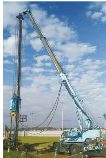
ラフター型杭打機
