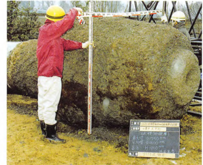
▼杭径1,000mmの球根築造掘出し状況
