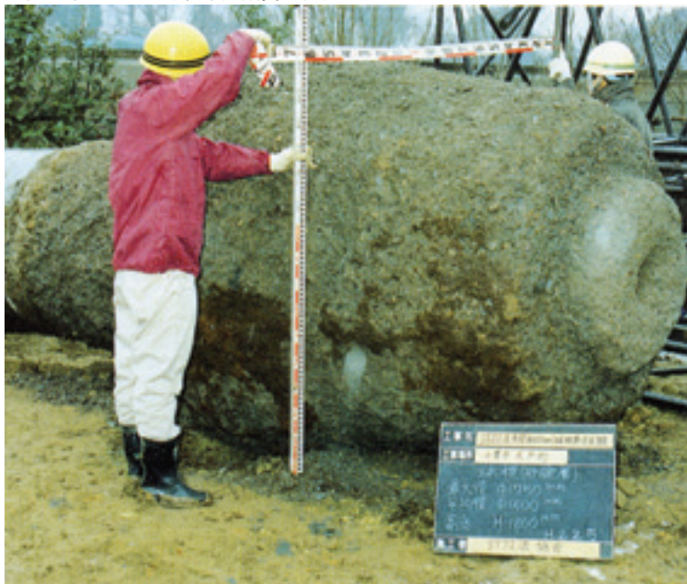
▼杭径1,000mmの球根築造掘出し状況
