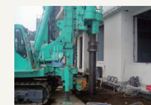
耐震補強工事
