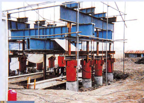
載荷試験装置
