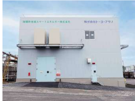
B スマートエネルギー建屋 (発電所)
