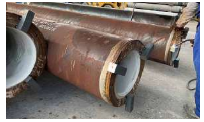
④ 施工用金具取付 (回転金具、FC)
