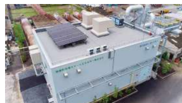
天然ガスコージェネレーション設備 外観
